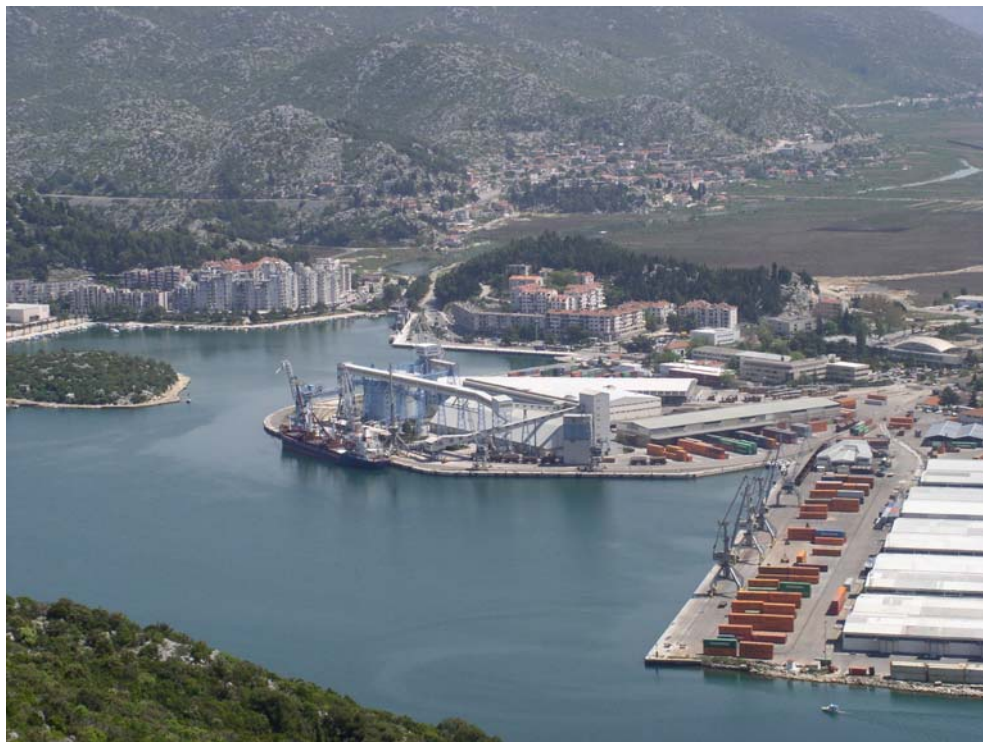
Slika 3 .Pogled na luku
