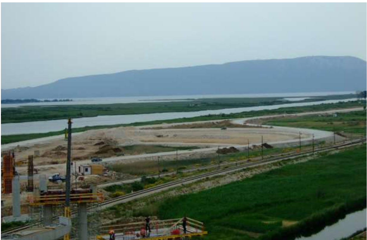
Slika 6. Gradilište čvora Čoveljuša i spojne ceste za luku Ploče.
