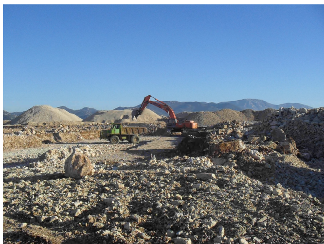
2 . Slike strojeva na radovima iskopa, štemanja i transporta
