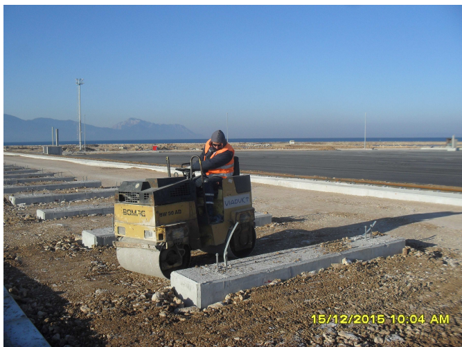
1 . Slike strojeva na radovima otklanjanja mulja pod vodom, izradi školjere, izradi nasipnog sloja unutar kranske staze
